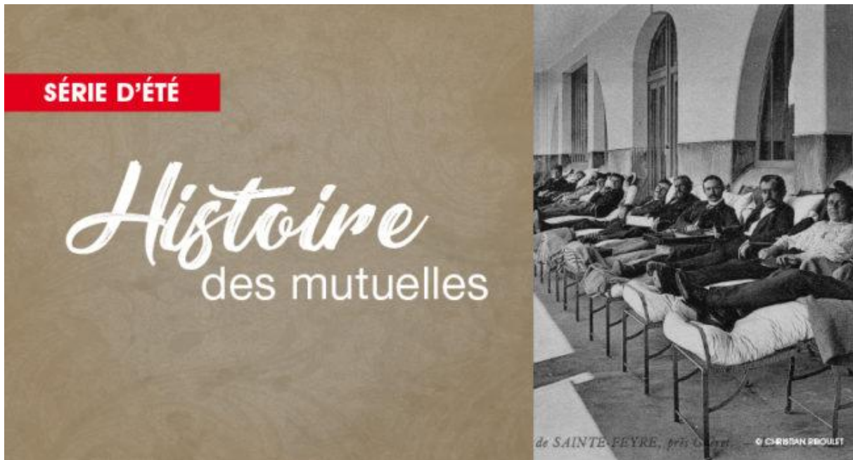
Une galerie de cure du sanatorium de Sainte-Feyre. Copyright : Christian Riboulet.
